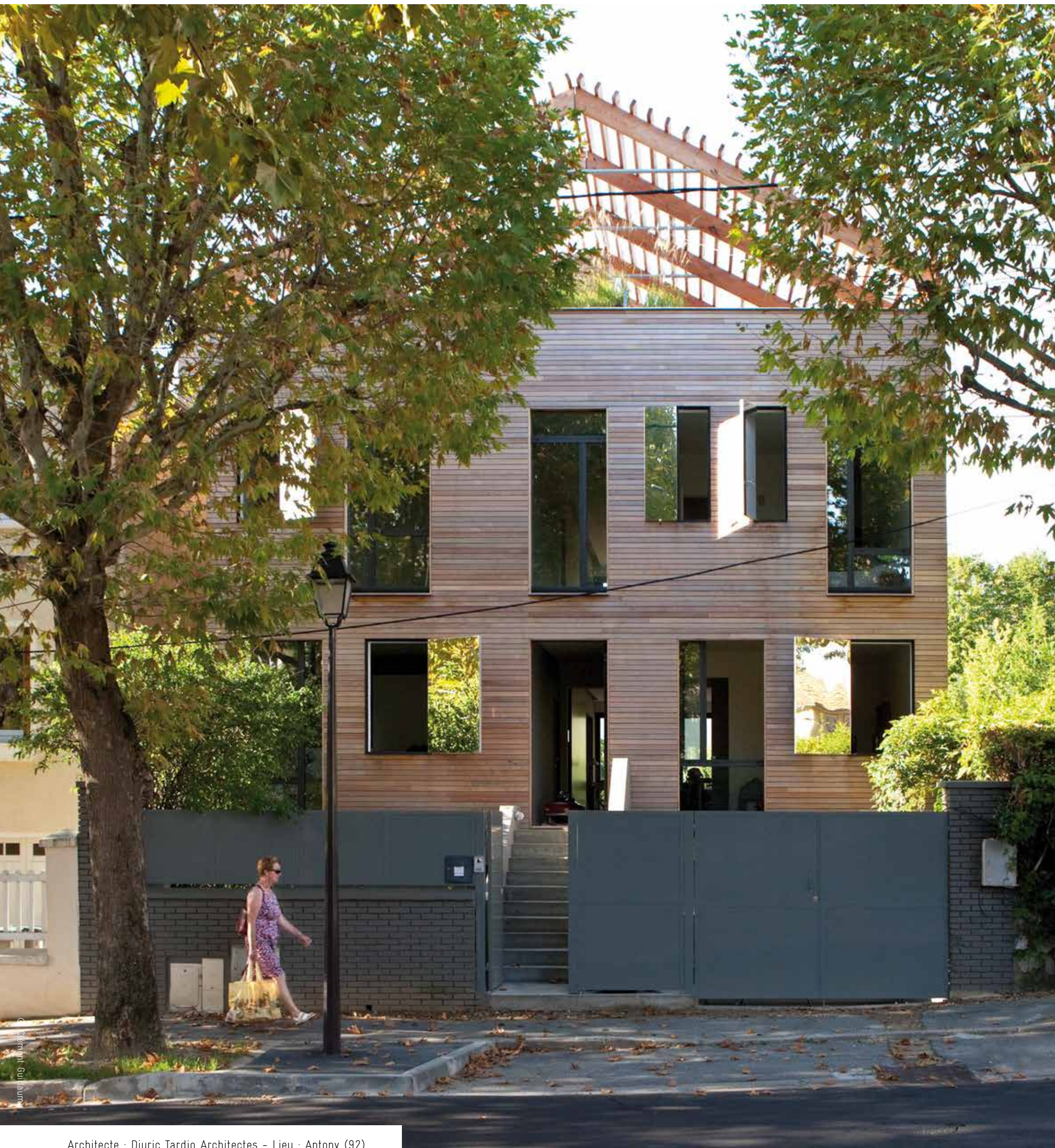
Architecte : Djuric Tardio Architectes - Lieu : Antony (92)
